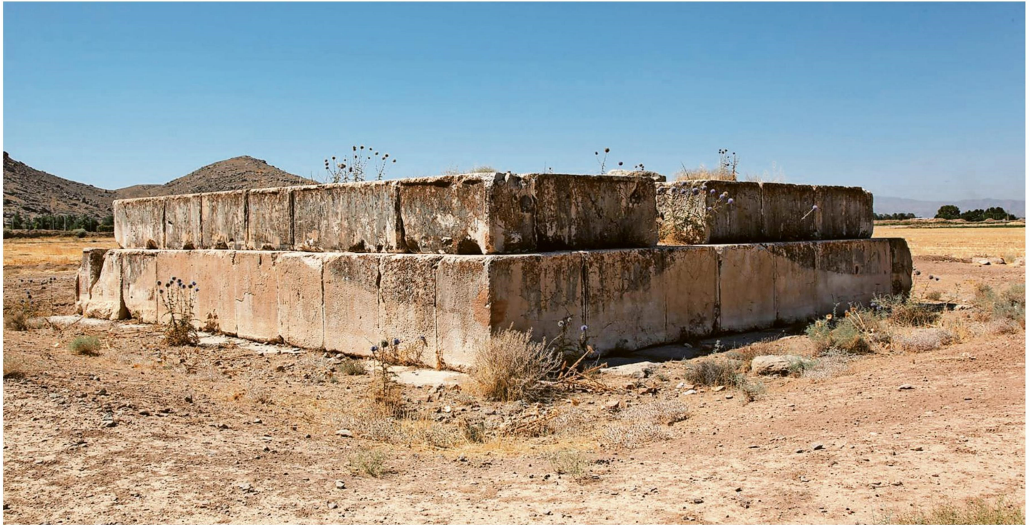
Früher waren hier grüne Weiden und fruchtbare Äcker. Trotzdem kamen die Bauarbeiten für das Grab eines noch nicht sicher identifizierten Perserkönigs über die zweite Stufe nicht hinaus.
